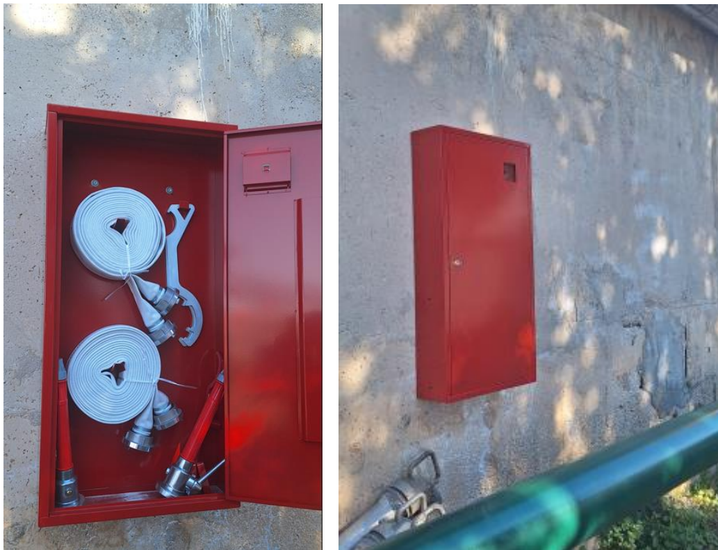
Slika 1. Hidrantski ormarići
